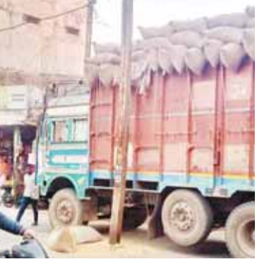
निर्माण कार्य कराया गया है। इस तरह से मांडल सड़क का निर्माण कार्य अनदेखी के कारण पूरी
